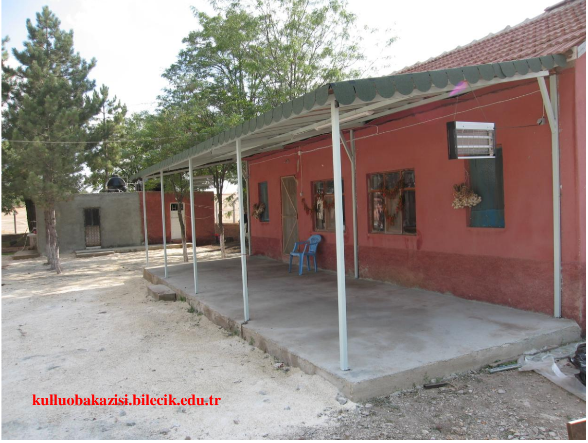
Resim. 29. Sundurma ve arka planda, solda ilave duş binası inşaatının bitirilmiş hali.
