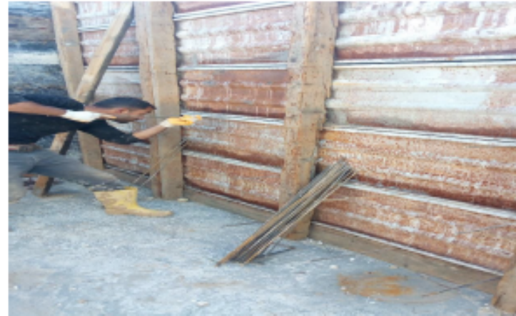
Şekil 1: Tie-rot (ti) demiri uygulaması
