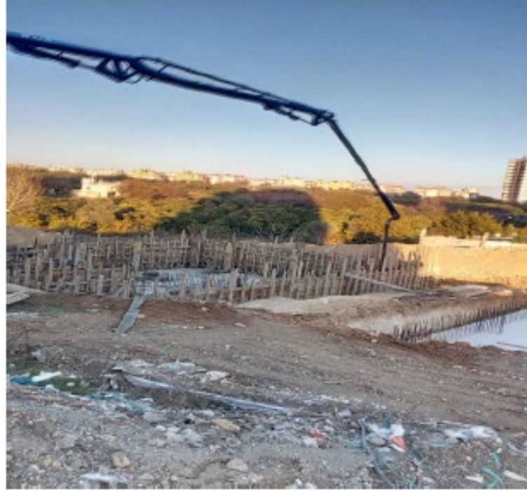
Şekil 8: Beton döküm işlemi
