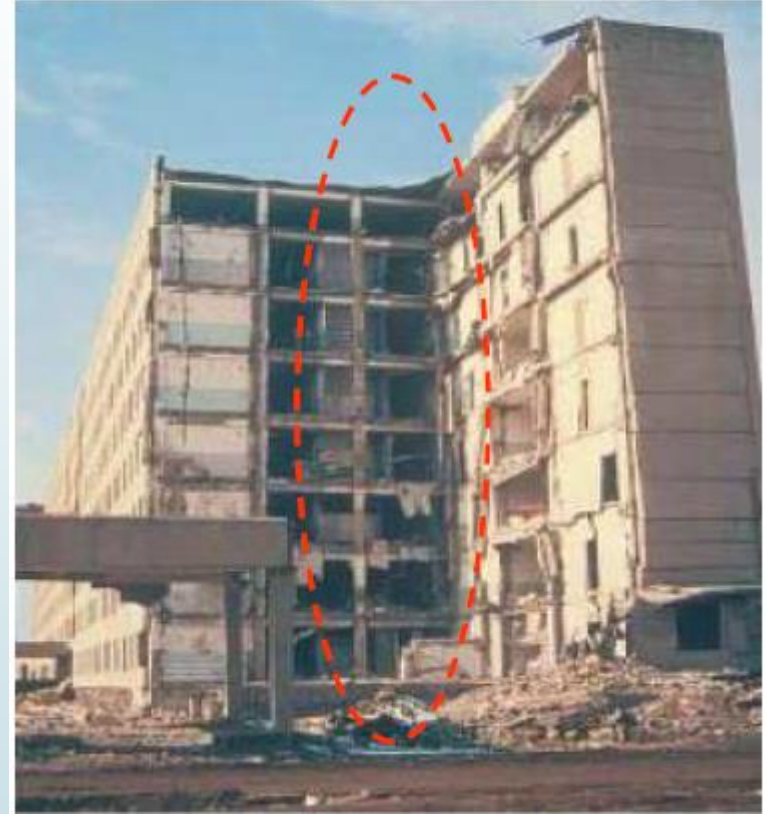
Deprem derzi olmayan L tipi yapı hasarı
