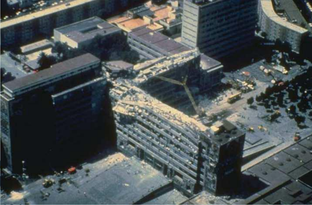
Deprem derzi olmayan Z tipi yapı hasarı, Meksika
